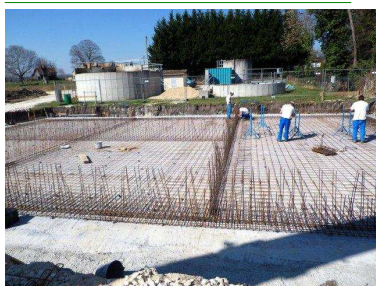
Station d'épuration : Réalisation des bassins filtrant
