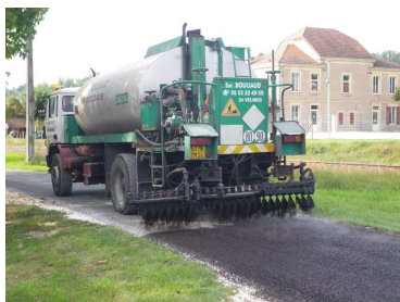
Travaux réfection route
