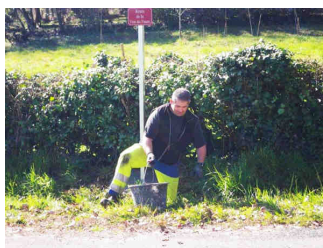
Pose des panneaux
