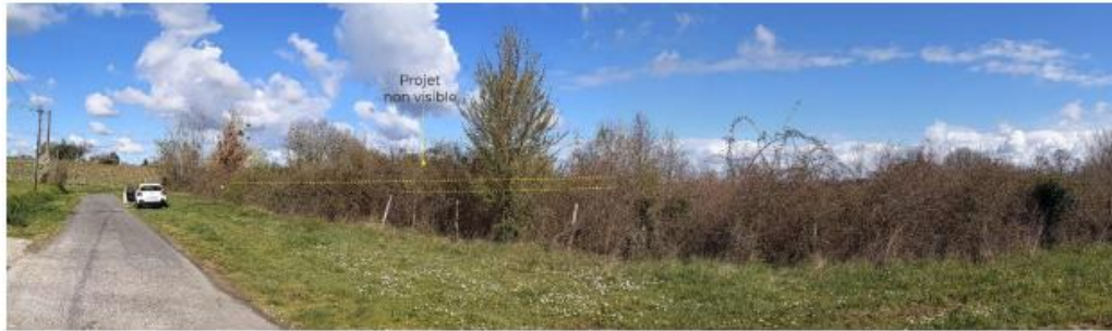
Figure 170: Vue panoramique depuis la route de Fonguillane - la friche agricole et le relief masque le projet (vue 1)
